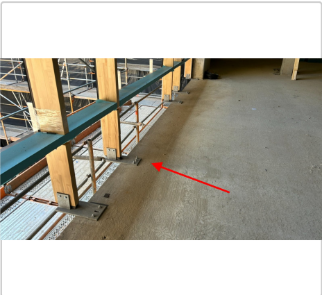
Wykonana praca 1: Montaż dolnych konsol dla elewacji PR na hali sportowej, widok południowy, A25–A27 26.06.2026, 08:35
