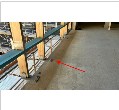
Travail exécuté 1 : Montage des consoles inférieures pour la façade PR au gymnase, vue sud, A25–A27 26/06/2026 08:35
