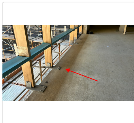
Ausgeführte Arbeit 1: Montage der unteren Konsolen für die PR-Fassade an der Sporthalle, Ansicht Süd, A25–A27 26.06.2026, 08:35
