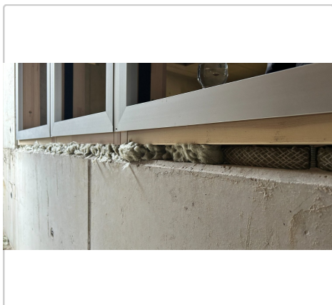
Ausgeführte Arbeit 3: Olepovanie namontovanych fasad na športovej hale pre vrch PR fasad, pohľad juh A22 02.06.2026, 21:52
